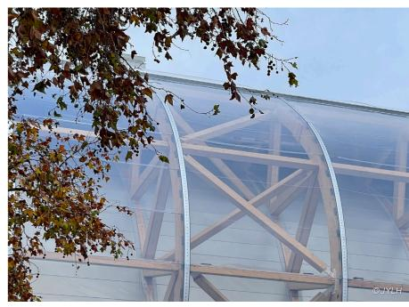
Questi archi triangolati, alti 3 metri, sono collocati su colonne in acciaio rivestite in legno, sostenute da micropali. Installati a intervalli di 4,5 metri, sono collegati da un plinto in cemento. L'intero edificio è coperto da un rivestimento in PVC (polivinilcloruro) sul tetto e da pannelli in ETFE (etilene tetrafluoroetilene) sulle pareti laterali che rendono la
