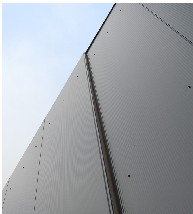
Differenze di spessore tra un pannello in schiuma e un pannello sandwich con anima in lana di roccia non combustibile
