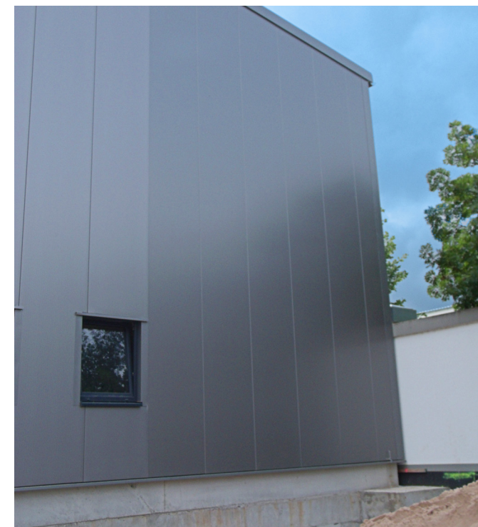
Niezamierzone różnice kolorystyczne pomiędzy płytami warstwowymi z pianki i wełny skalnej
