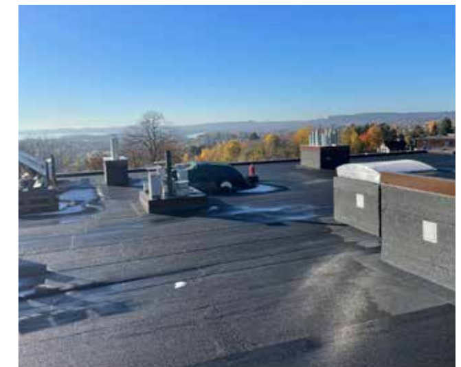
Når oppgraderingen er ferdig, er taket klart til å tåle vær og vind i de kommende tiår.
