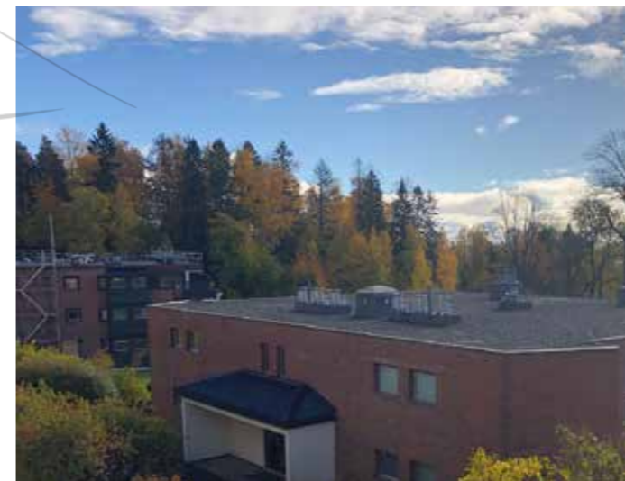
Takene i Lyse Terrasse er klare for tilleggisolering og nytt dekke.
