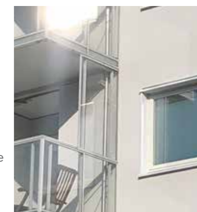
Nye vinduer og ny ROCKWOOL isolasjon har gitt leilighetene bedre lydtetthet.
