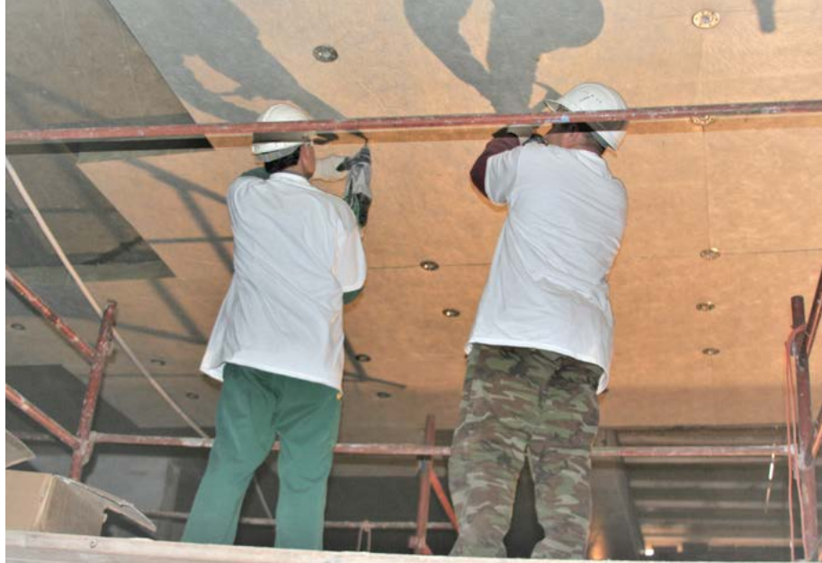
Rockorbit kan monteres direkte på betong-stål eller trelekter med skive og tilpasset skruer.
