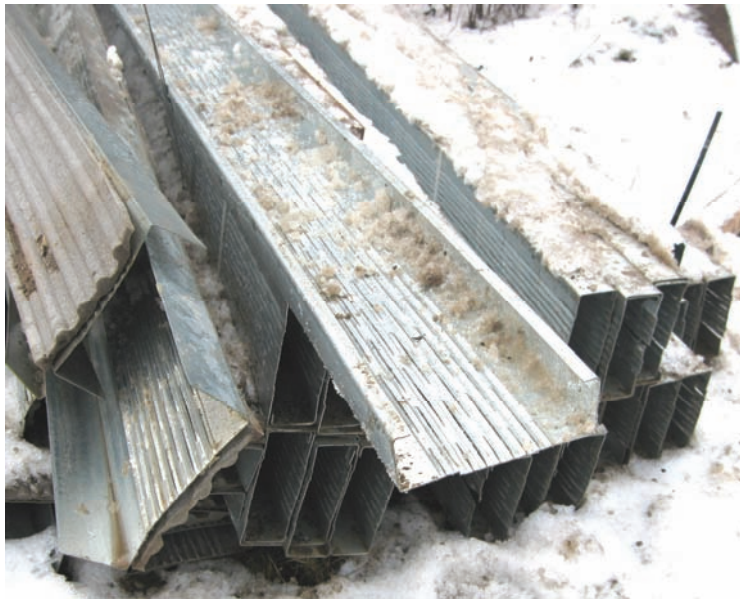
Figur 1. Slissede tynnplateprofiler lagret på byggeplass: Topp- og bunnsvill til venstre, stender i midten og til høyre.
