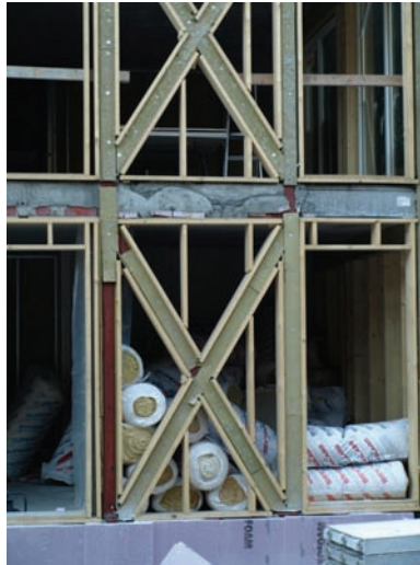
Figur 7. Bilde av søyler og avstivingkryss av stål. Brannisolasjon legges rundt stålprofilene.
