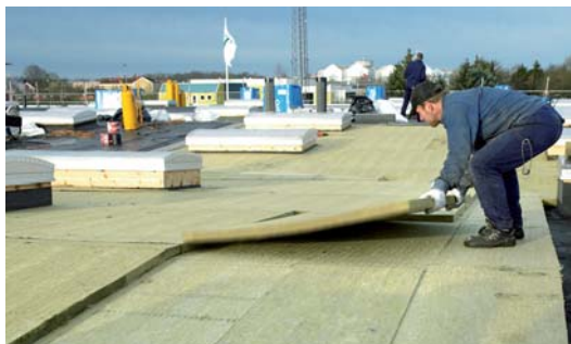
Bildet viser utlegging av Rockwool takisolasjon i flere lag før tekning blir lagt ut og festet.
