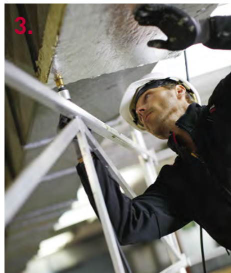
Håll upp skivan mot ventilationskanalen och skjut fast den med en svetspistol.
