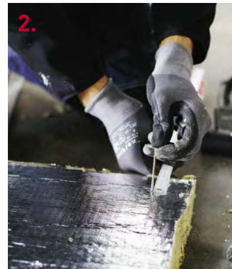
Använd svetsstift med i rätt längd. De kan med fördel sättas dit innan skivan lyfts upp.
