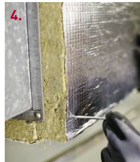
Montera skivorna så att de överlappar vid alla skarvar. Skivorna fixeras tillfälligt genom att en spik trycks genom båda skivorna innan svetsstift monterar. Skarvar fogas avslutningsvis med CONLIT fogmassa.
