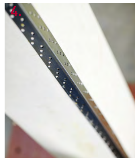
4. Hörnskydd kan avslutningsvis limmas eller skruvas på enligt fabrikantens anvisningar.
