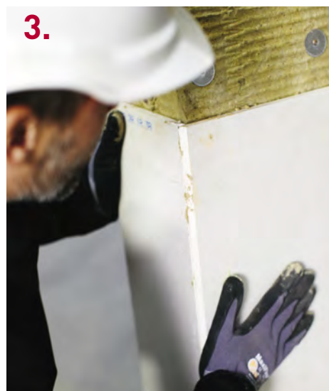
3. Tryck därefter på hela skivans yta så att det blir bra kontakt mellan lim och gipsskiva.
