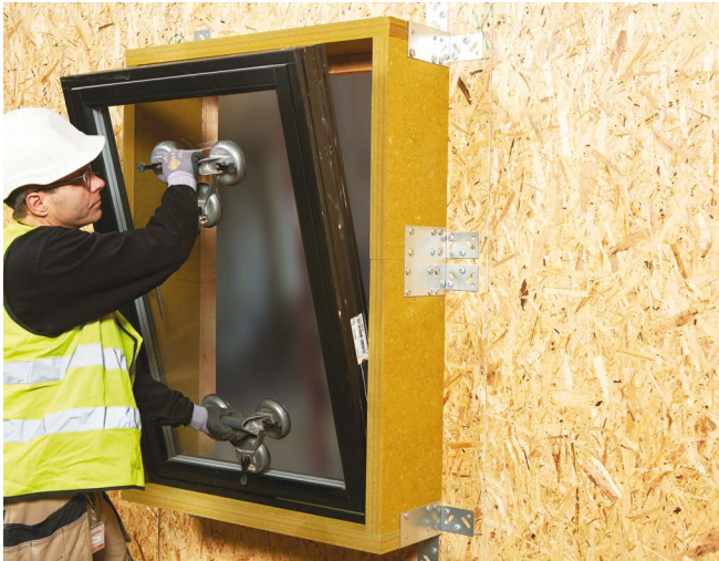
Fönstret lyfts på plats i REDAir Link ramen.
