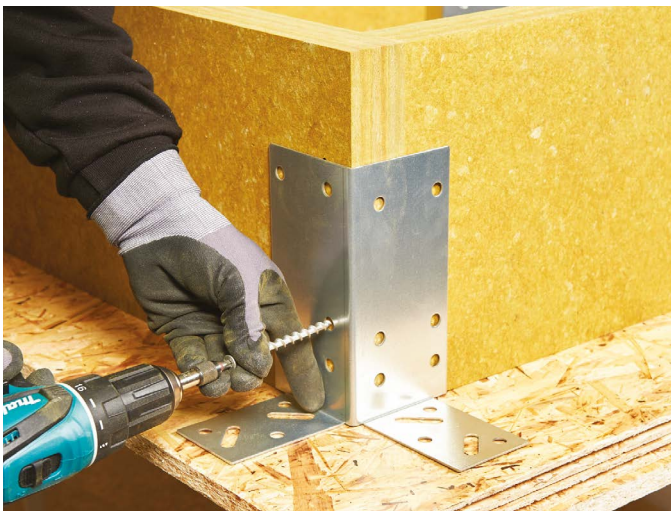
Montering sker med REDAir Link Hörnbeslag och medföljande skruv.
