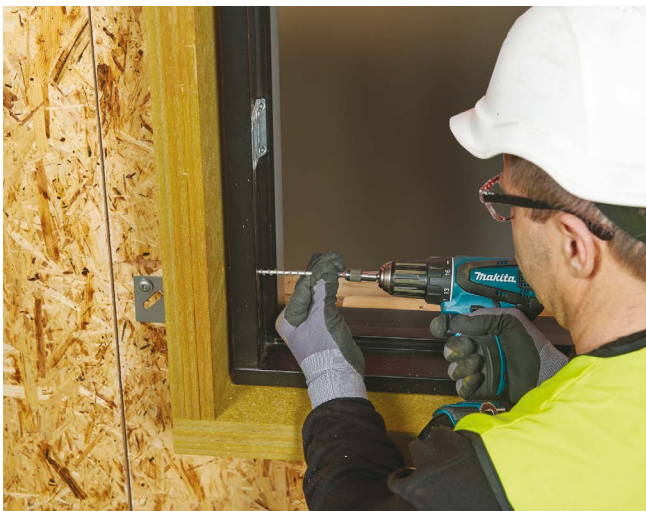
Montage av fönster i REDAir Link Board med grovgängade lättbetongskruvar.
