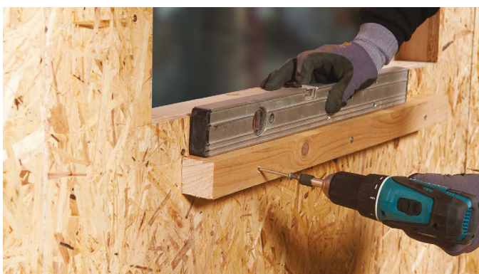
Exempel på tillfällig monterad läkt för stöttning av REDAir Link Board.
