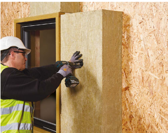
Montering av REDAir Flex System (Redair Batts) omkring REDAir Link Board.
