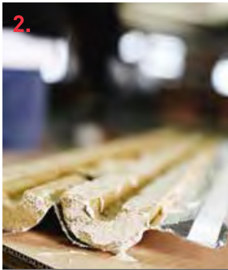
Conlit Klæber påføres på alle flader og ender.
