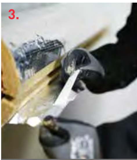
Rørskålen sættes omkring træk/trykstangen og lukkes. Fjern beskyttelsesfilmen fra aluminiumsflappen og tryk den fast over samlingen.
