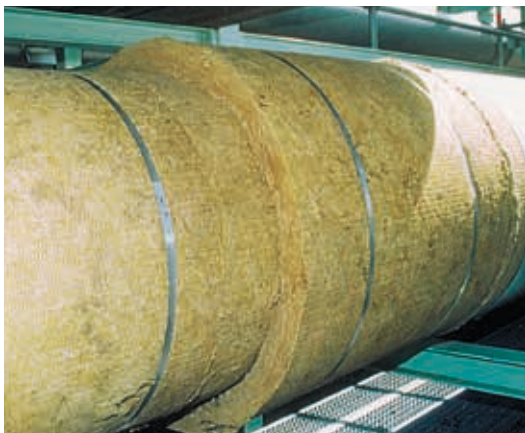
Store rørskåle fastgøres med metalstrips
