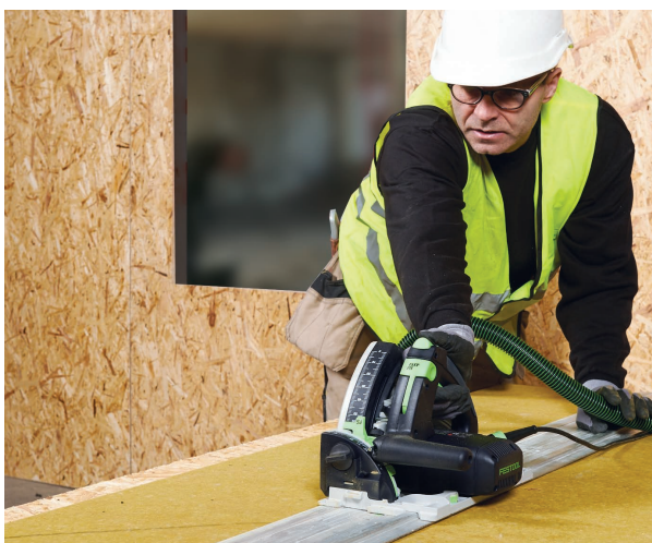
Redair Link -levyn työstämiseen ei tarvita erikoistyökaluja, vaan tavalliset työkalut riittävät.
