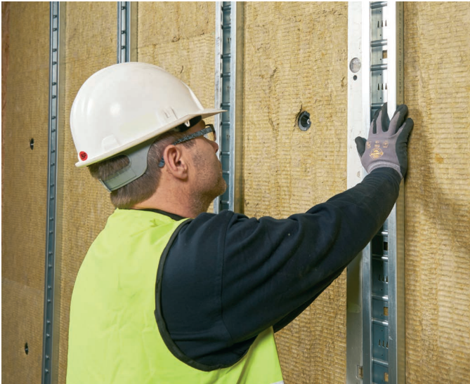
Asenna teräsrankat eristeen päälle pystysuuntaisesti.
