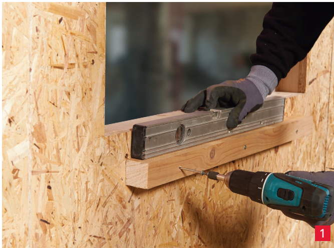
Esimerkki: Redair Link -järjestelmän tilapäinen asennustuki.
