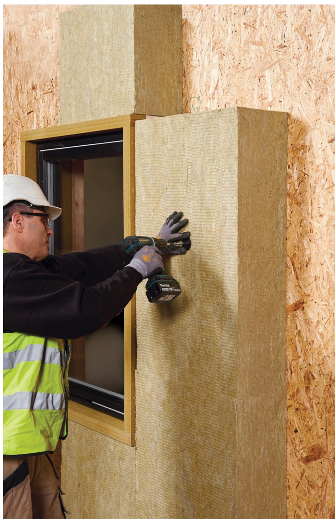
Redair Batts -eriste asennetaan tilapäisesti käyttäen Redair-ruuvia ja Redair Flex -muovilaattaa.
