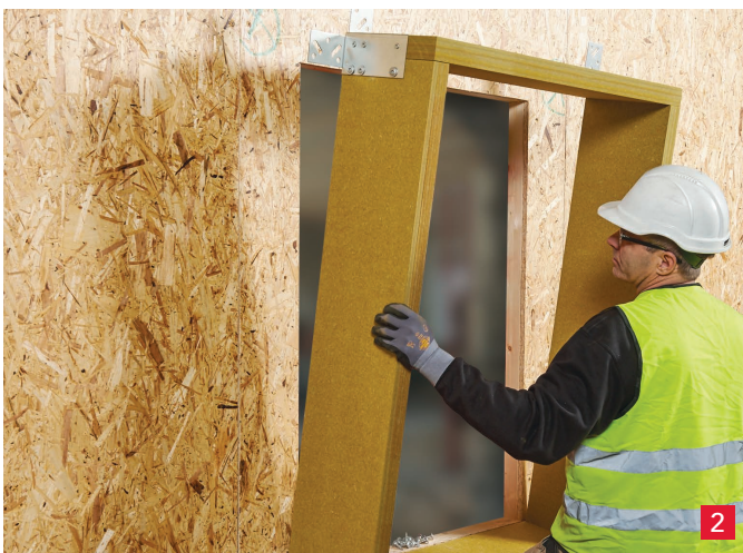
Redair Link -järjestelmä nostetaan paikalleen.
