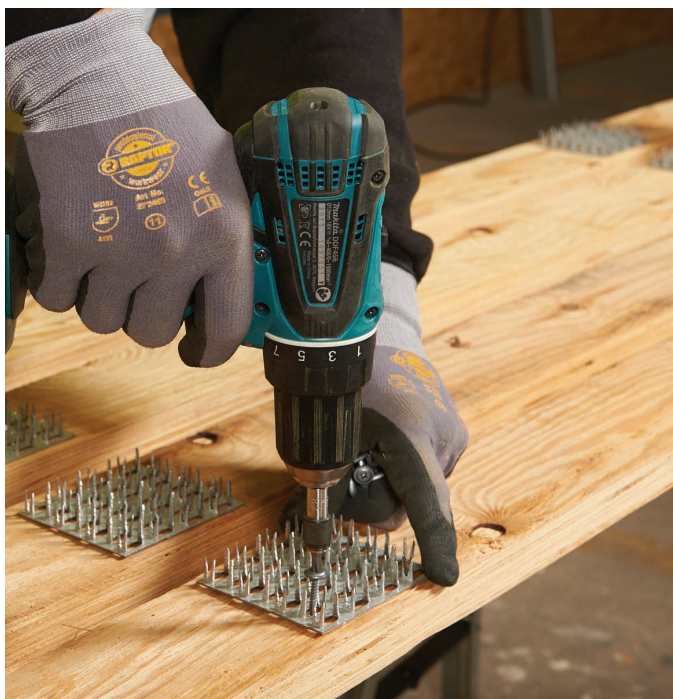
Asenna kitkalevyt rangan taustapuolelle.
