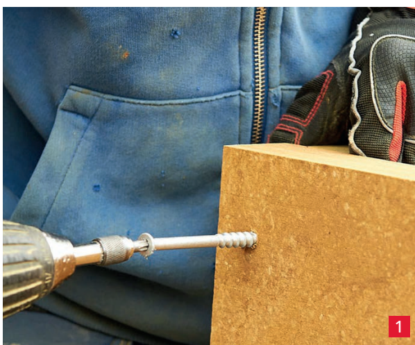
Levyt kiinnitetään toisiinsa ruuvilla ennen kulmakiinnikkeen asennusta.
