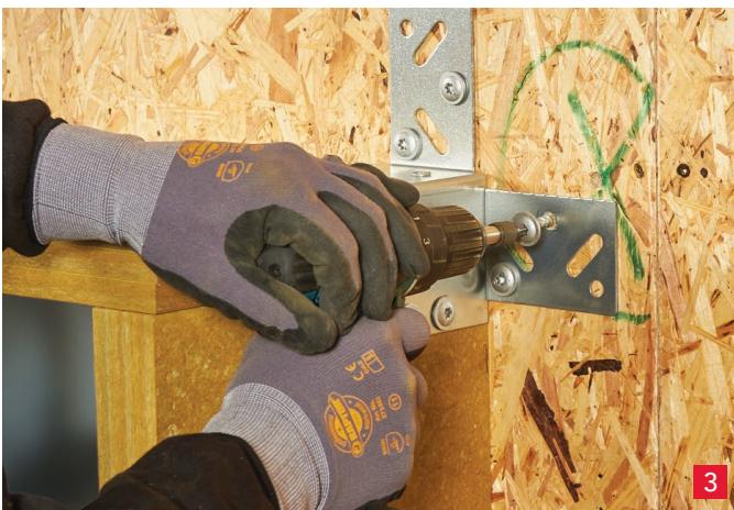
Redair Link -järjestelmä kiinnitetään seinään kulmakiinnikkeistään kohdekohtaisilla ruuveilla.
