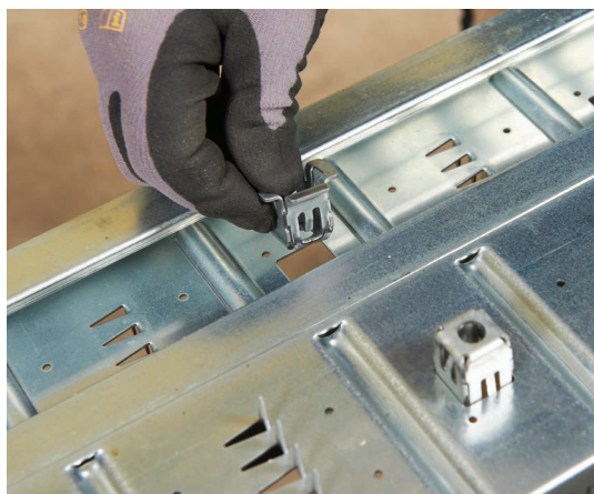
Klipsit painetaan kiinni teräsrankassa oleviin reikiin.
