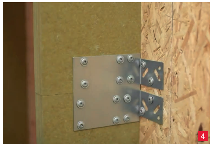
Jos jatkokiinnikkeitä käytetään, kiinnitetään Redair Link -järjestelmä jatkokiinnikkeistä seinään kohdekohtaisilla ruuveilla.
