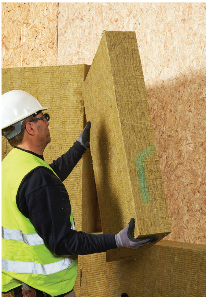
Redair Multi -eristejärjestelmän asennus aloitetaan eristeen asentamisella
