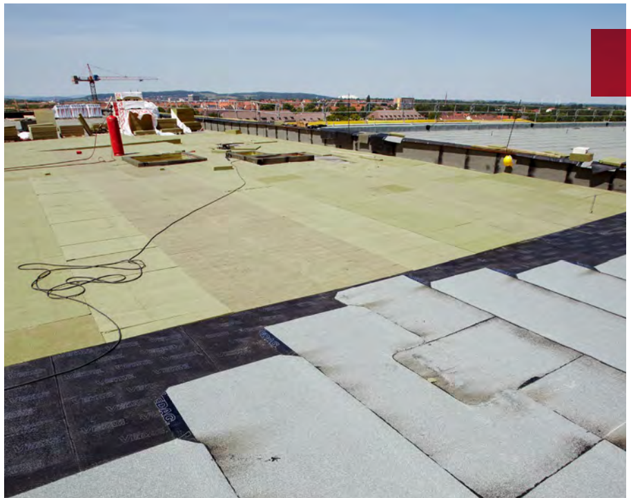
Loose Bestandteile werden zunächst von der alten Dachfläche entfernt.
