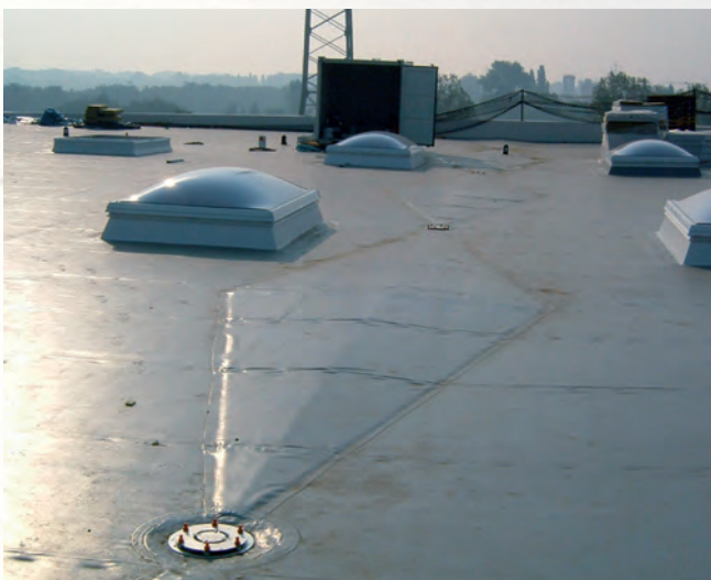
Punktentwässerung entlang der Kehllinien
