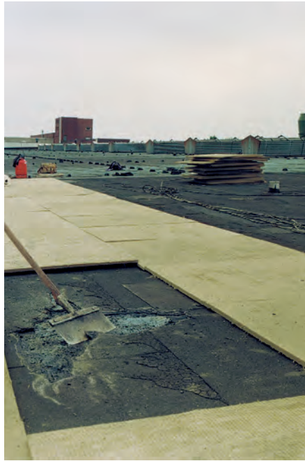
Loose Bestandteile werden zunächst von der alten Dachfläche entfernt.
