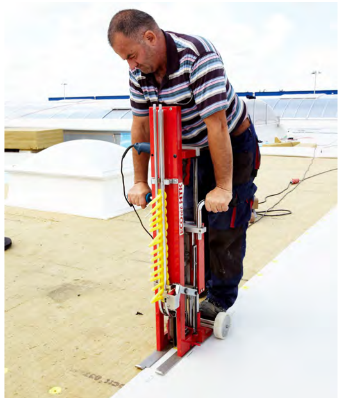
Dachaufbau mechanisch befestigt
