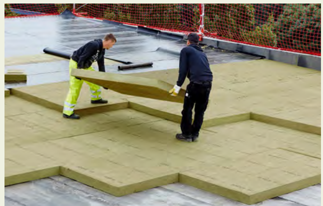
Die Verlegung der Dämmplatten erfolgt im Verband.
