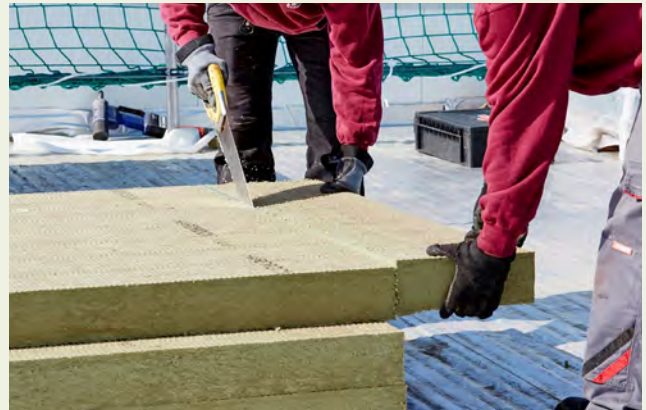
Die Dämmplatten lassen sich leicht zuschneiden.
