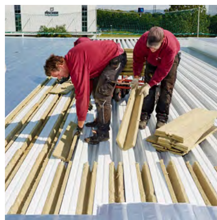
Einlegen von Akustik-Profilfüllern in Trapezprofile
