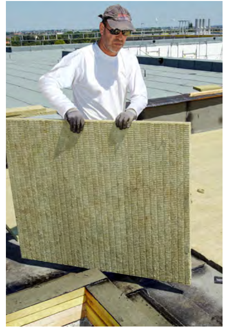
Verlegung der RP-TF auf ausgebessertem altem Dachaufbau
