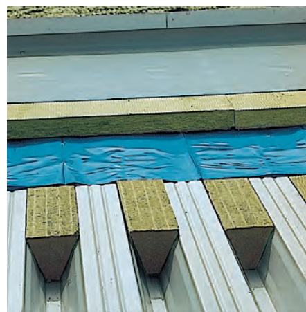
Brandschutz-Profilfüller zum Lastabtrag
