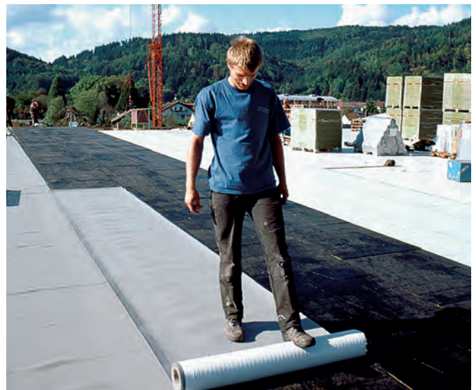
Dachaufbau verklebt
