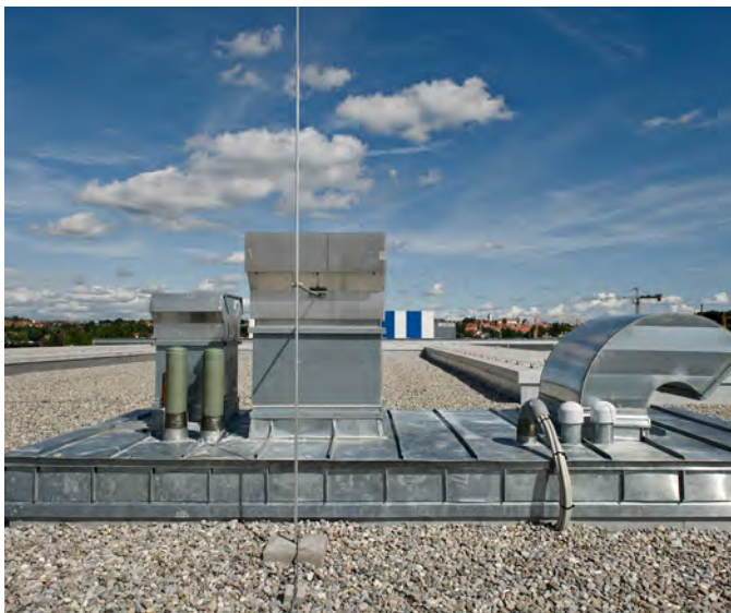
Dachaufbau lose verlegt mit Auflast
