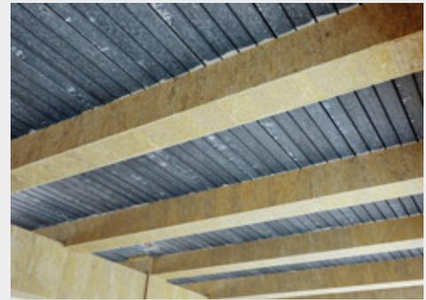
**Variante 1 :** Remplissage des cannelures avec une bande en laine de roche supplémentaires
