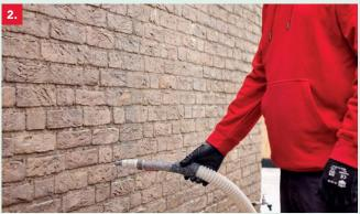
La cavité est remplie par des ouvertures forées au moyen d'une machine d'injection avec tuyau et buse.
