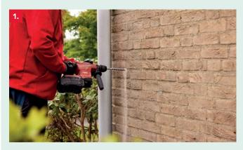
Des trous sont forés à intervalles réguliers dans intersections entre les joints de mortier horizontaux et verticaux.
