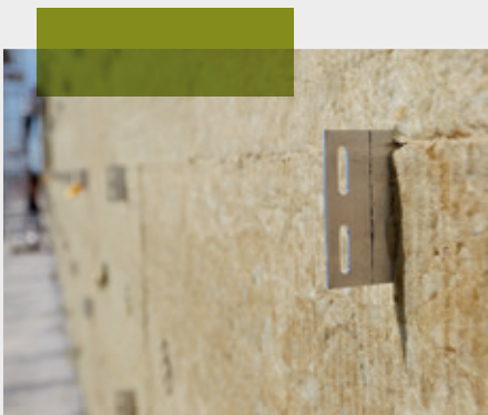
Traditioneel aluminium bevestigingssysteem
