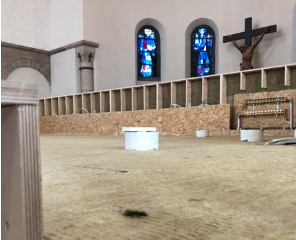
Om het contactgeluid vanaf de tussenvloer naar de onderliggende ruimte te beperken zijn platen Rockfloor Solid gebruikt.
