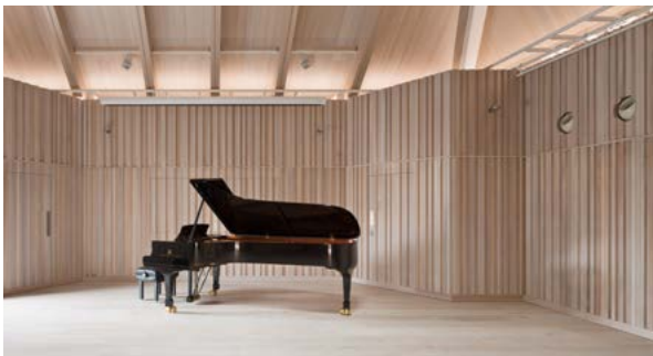
Tijdens de verbouwing werden ruimten met een optimale akoestiek gecreëerd, die volledig geluiddicht zijn.
