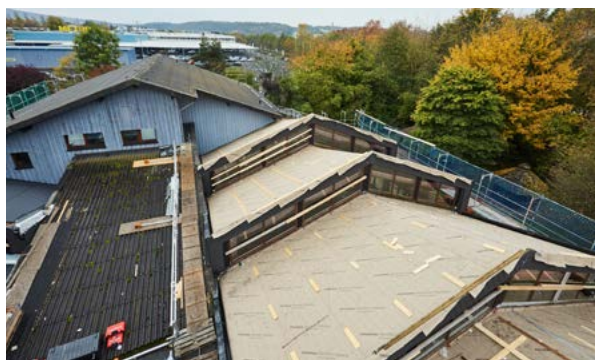
Van bovenaf is goed te zien hoe verschillend de daken zijn. Kühne GmbH heeft in totaal ongeveer 5.500 m 2 dakoppervlak gerenoveerd.
