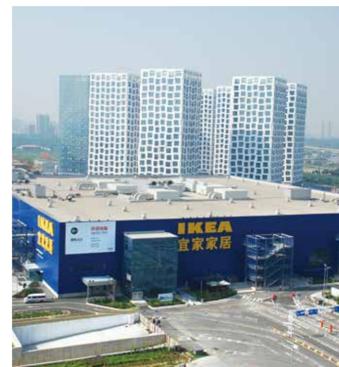
IKEA(Beijing ,Tianjin ,Nanjing,etc)
