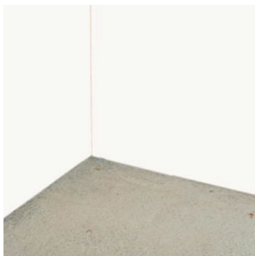
Příprava rovného podkladu je naprosto nezbytná (obr. 26)
