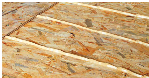
„Housenky“ lepidla pro slepení 2 vrstev OSB desek (obr. 19)
