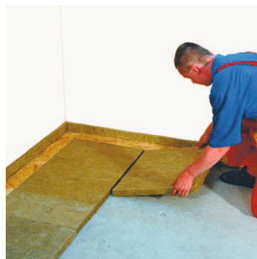
Položení akusticky izolační vrstvy Steprock HD z minerální vlny (obr. 30)
