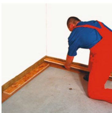
Položení horní části okrajového pásku z OSB desky (obr. 29)
