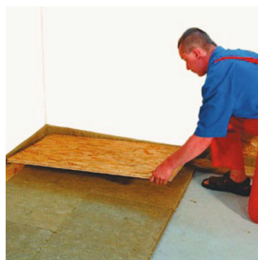
Pokládka první roznášecí vrstvy deskou OSB SUPERFINISH® (obr. 31)
