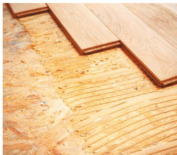
Plošné lepení dřevěné podlahy (obr. 34)
