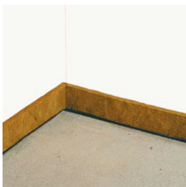
Osazení dilatačního pásku Steprock (obr. 27)
