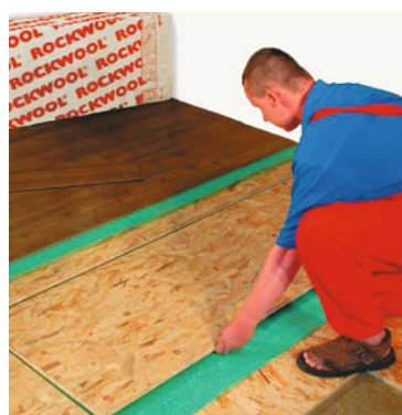
Pokládka druhé roznášecí vrstvy (kolmo k první) deskou OSB SUPERFINISH® (obr. 32)
