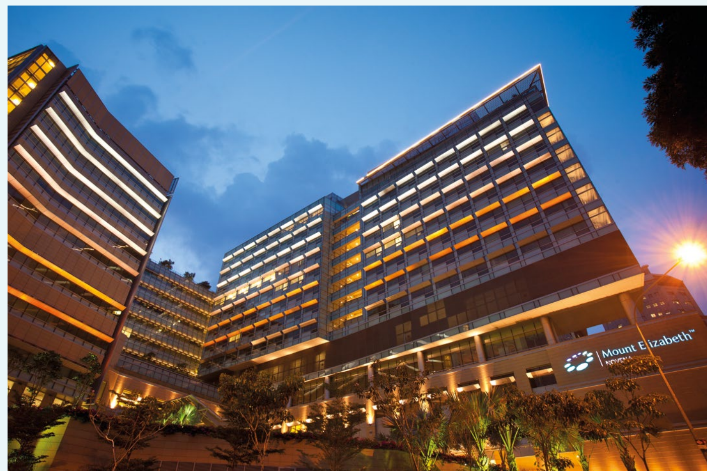
Singapur. Produkty: flexibilní potrubí ROCKWOOL Bradflex | ThermaRock S | Izolace vnitřního potrubí HVAC
