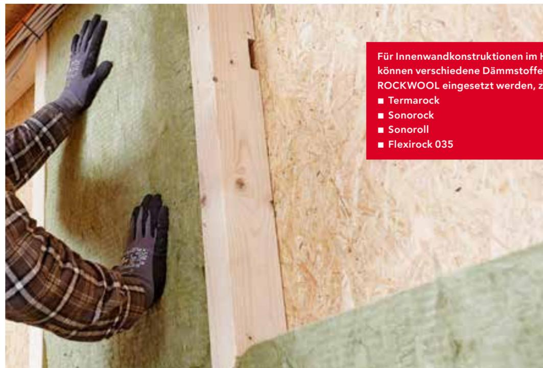
Für Innenwandkonstruktionen im Holzbau können verschiedene Dämmstoffe von ROCKWOOL eingesetzt werden, z. B.:
