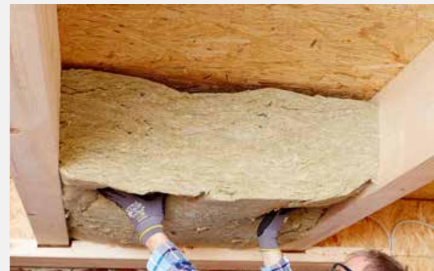
Die federnde Wirkung verschafft der Flexirock 035 einen festen und sicheren Halt zwischen den Stielen. Sie füllt das Gefach vollständig aus. Wärme- und Schallbrücken werden so vermieden.
