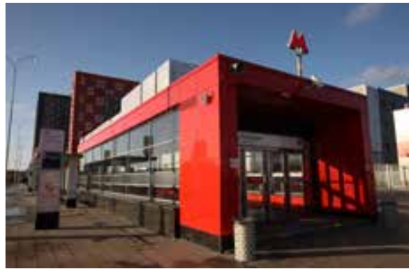
Die langlebigen ROCKWOOL Produkte aus Steinwolle sorgen an vielen Stationen der Moskauer Metro dafür, dass die Fassaden auch anspruchsvollsten Witterungsbedingungen standhalten können.
