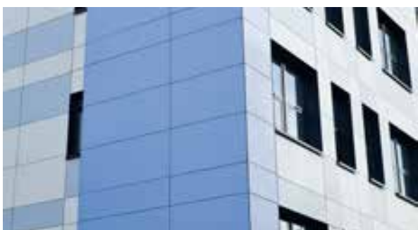
Rockpanel Premium A2 Fassadenplatten erfüllen die höchsten europäischen Brandschutzstandards und gewährleisten ein makelloses Fassadendesign ohne sichtbare Niete oder Schrauben.
