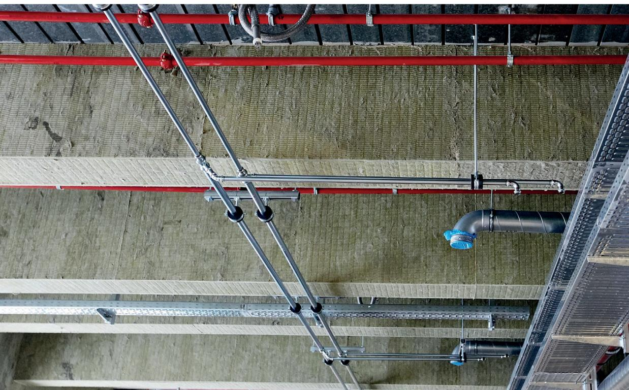
Das Conlit Steelprotect Board ist eine nichtbrennbare druckfeste Steinwolleplatte, für die verschiedensten Anwendungen im vorbeugenden baulichen Brandschutz. Sie wird als unkaschierte Variante (Conlit Steelprotect Board) und als einseitig mit gitternetzverstärkter Aluminiumfolie kaschierte Variante (Conlit Steelprotect Board Alu) angeboten.
