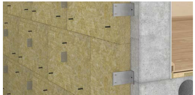
2. Põhisoojustuskihi plaatide paigaldamine
