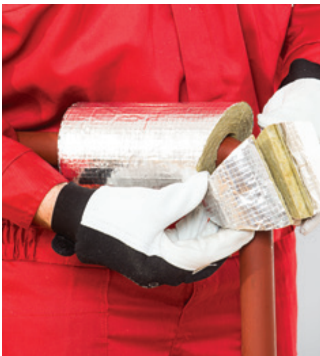
3. Torupõlve detaili paigaldamine.
