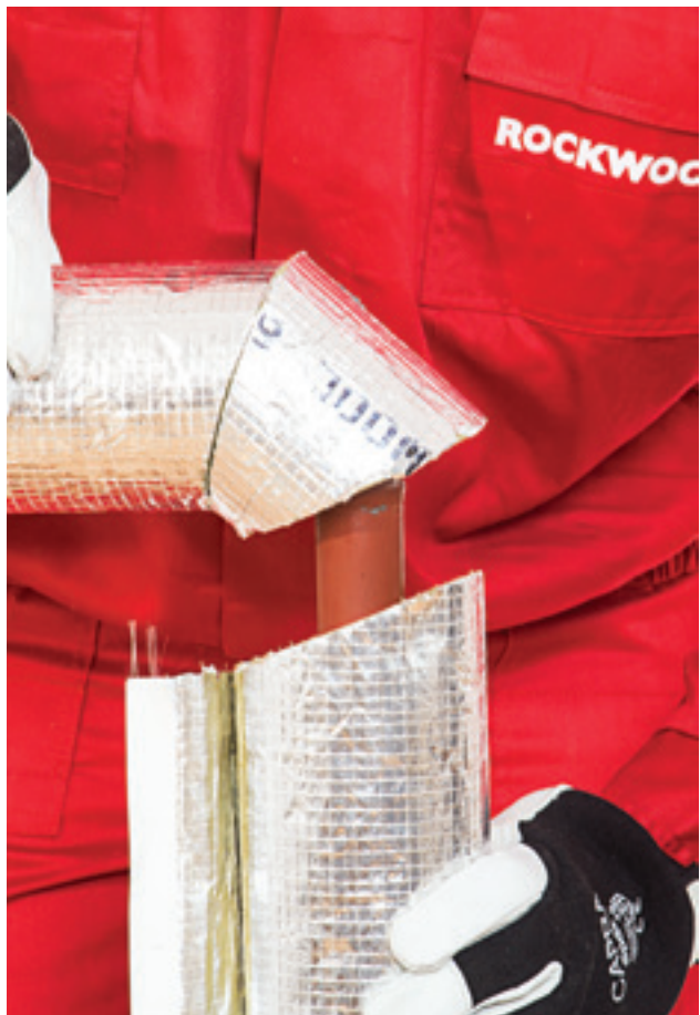
5. Isolatsiooni sirge osa paigaldamine.
