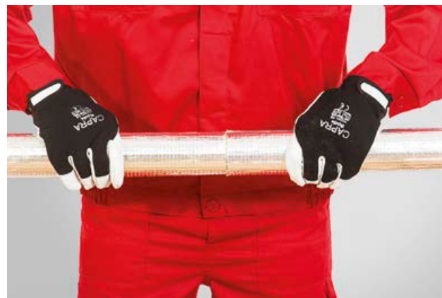
6. Kahe kõrvuti asetseva torukooriku otsad vajutatakse tihe- dalt kokku.
