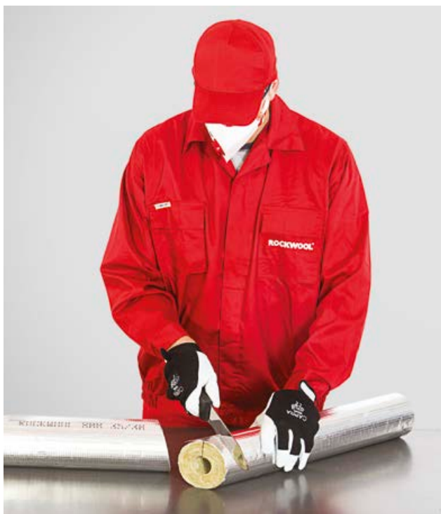
1. Torupõlve isolatsioonidetaili lõikamine, 1. samm.
