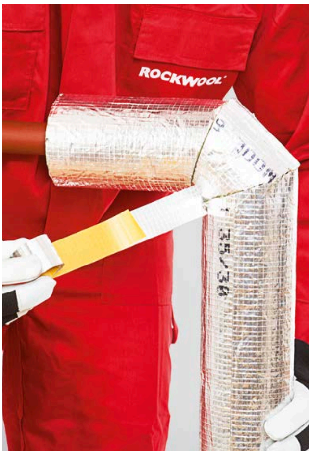
7. Ristiühenduste katmine alumiiniumteibiga.
