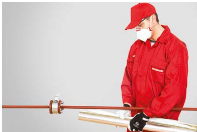
1. Torukoorik pannakse sirgele torule.
