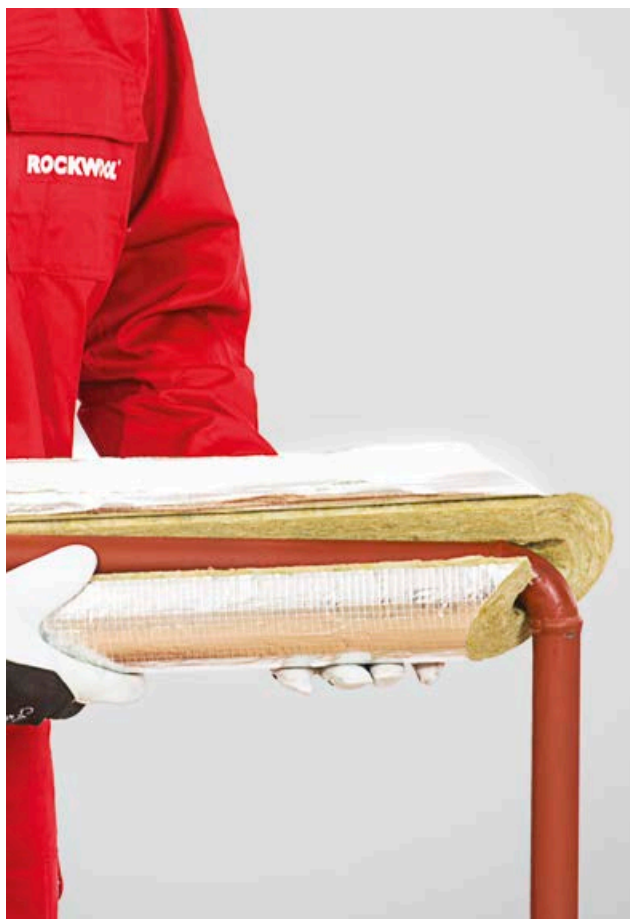
3. Isolatsiooni esimese osa paigaldamine torule.
