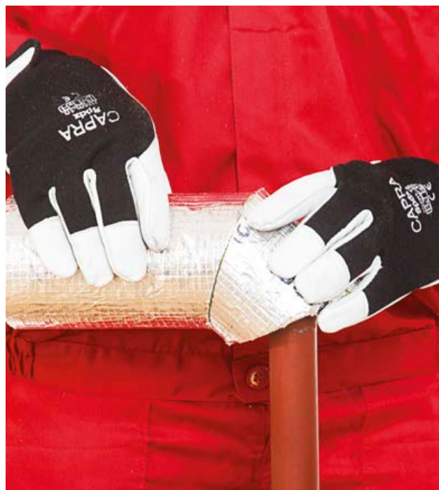
4. Torupõlve detaili täpne ühendamine torukooriku sirge osaga.
