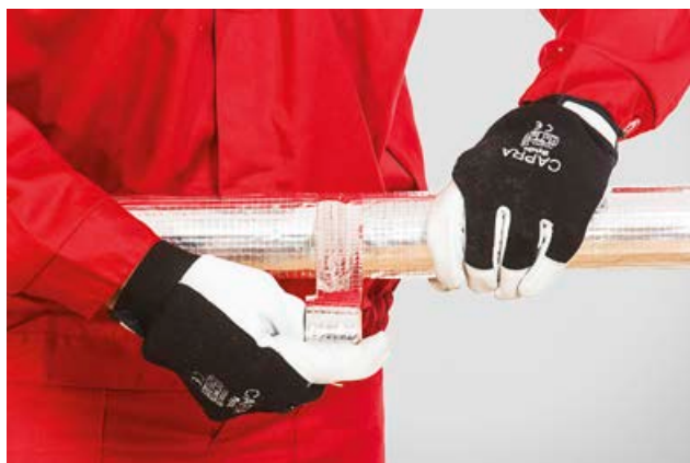
7. Torukoorikute ühenduskoht kaetakse alumiiniumteibiga.
