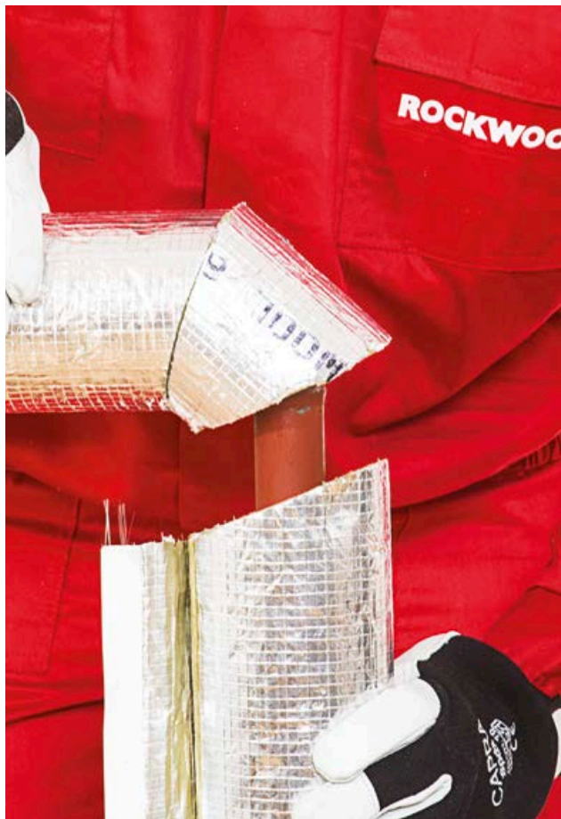
5. Isolatsiooni sirge osa paigaldamine.
