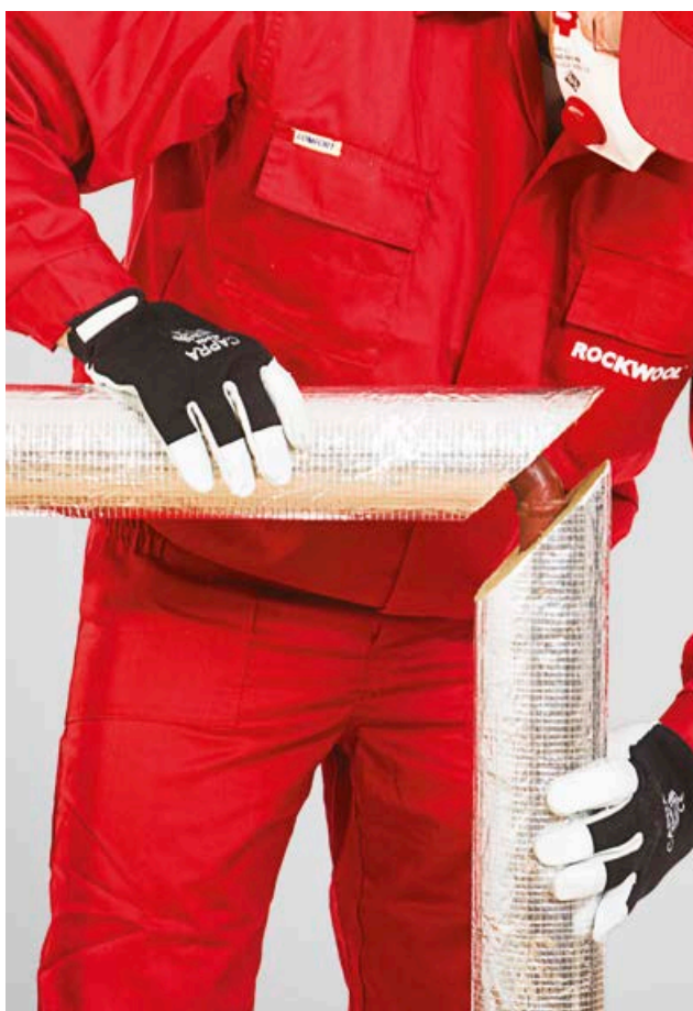
5. Torupõlve isolatsiooni mõlema osa ühendamise.
