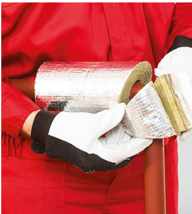
3. Torupõlve detaili paigaldamine.
