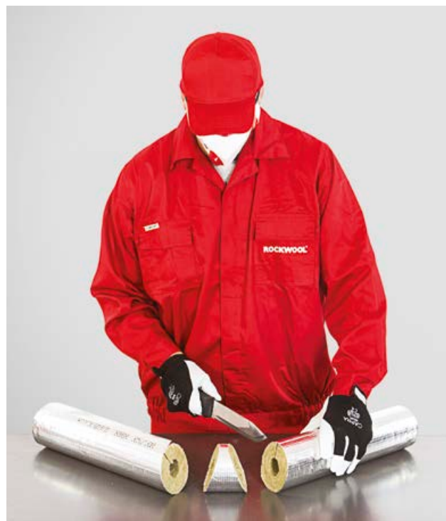
2. Torupõlve isolatsioonidetaili lõikamine, 2. samm.
