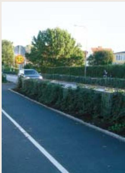
Las barreras ecológicas contra el ruido Rock-Delta en los laterales de las carreteras y las barreras de control de vibración RockDelta bajo las vías férreas ayudan a reducir el molesto ruido del tráfico.
