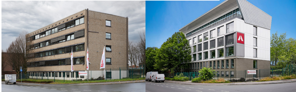
Oficina administrativa de ROCKWOOL en Gladbeck (Alemania), antes y después de la rehabilitación.
