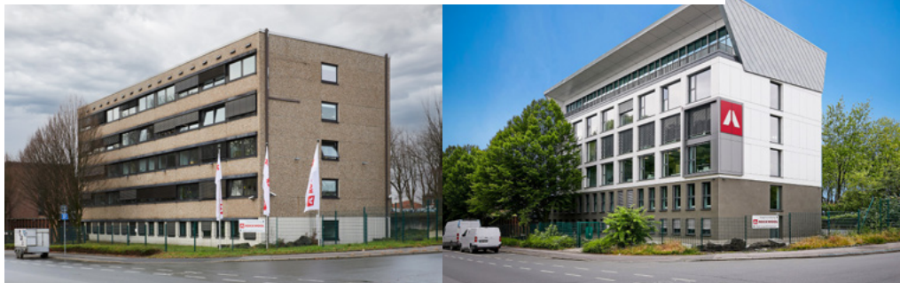
Bureau administratif du Groupe ROCKWOOL à Gladbeck, en Allemagne, avant et après la rénovation
