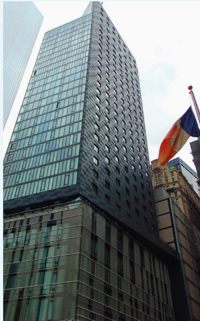
New York, États-Unis. Produits : Isolation ROCKWOOL | Isolation par l'extérieur CAVITYROCK
