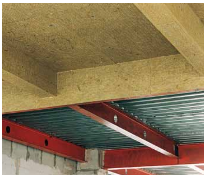
Exemple d'illustration de protection de poutres
