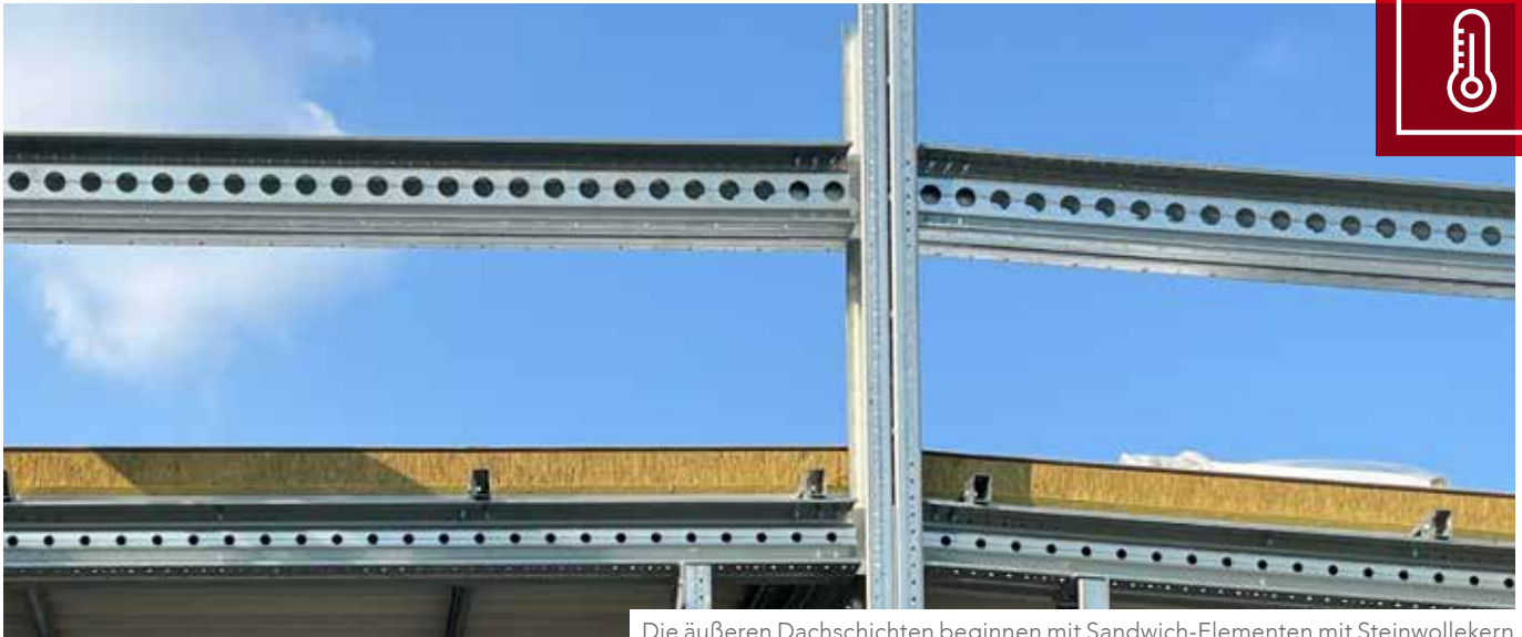
Die äußeren Dachschichten beginnen mit Sandwich-Elementen mit Steinwollekern
