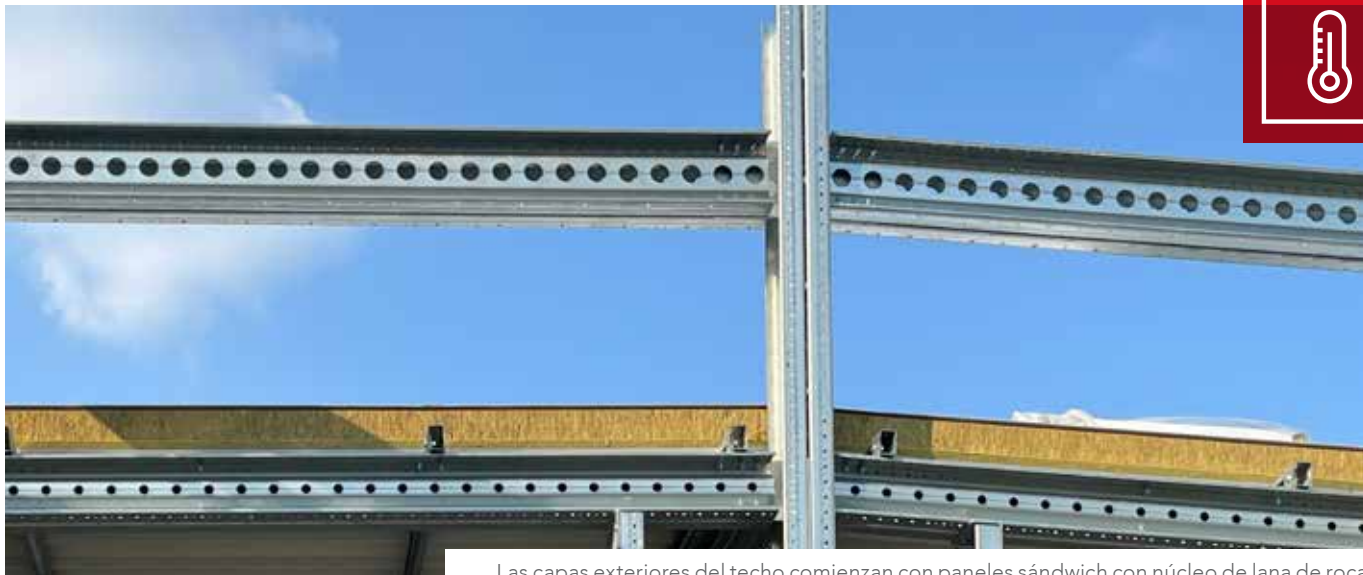
Las capas exteriores del techo comienzan con paneles sándwich con núcleo de lana de roca
