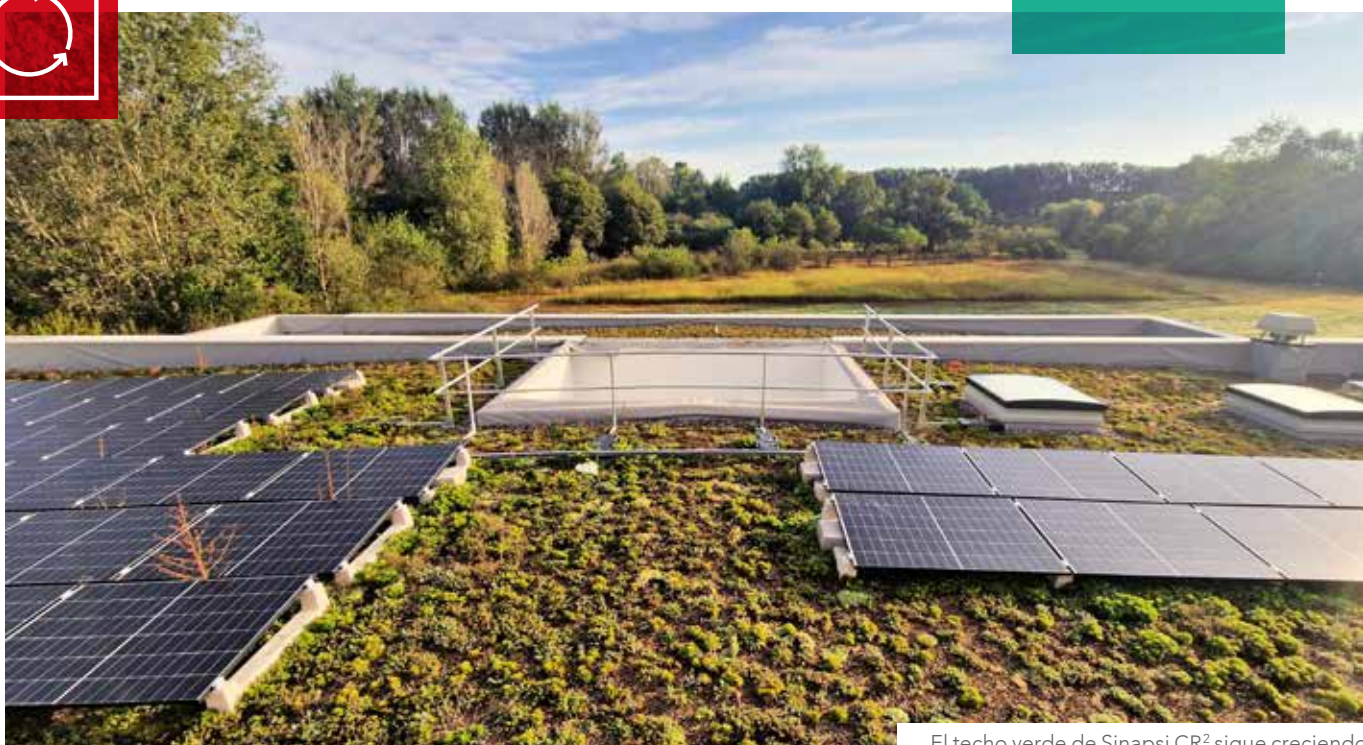
El techo verde de Sinapsi CR 2 sigue creciendo
