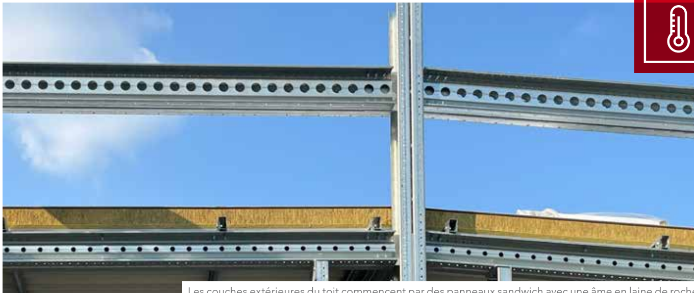
Les couches extérieures du toit commencent par des panneaux sandwich avec une âme en laine de roche
