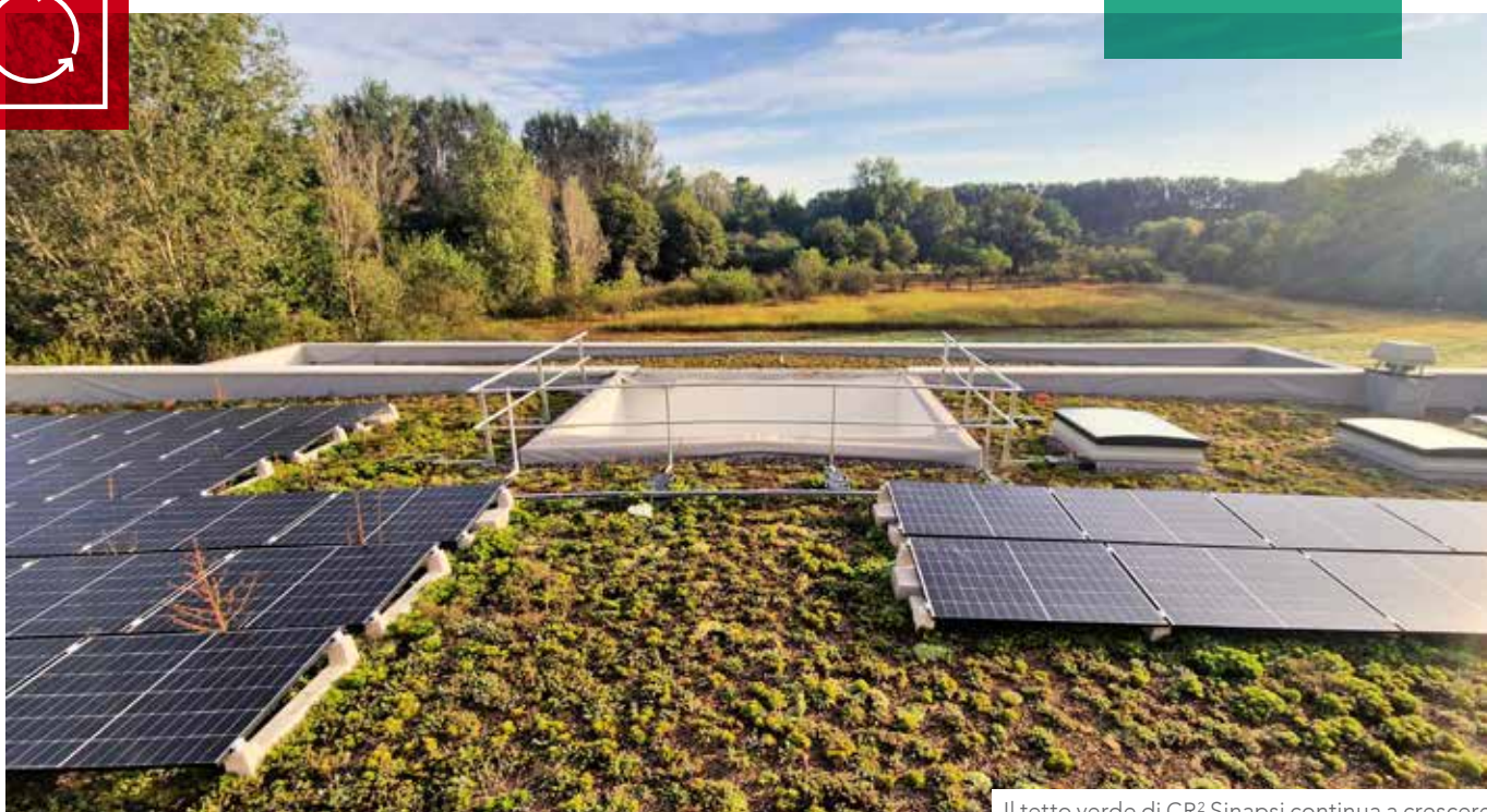
Il tetto verde di CR 2 Sinapsi continua a crescere
