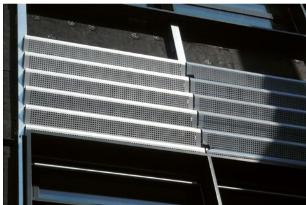
Detalj ventilirane fasade
