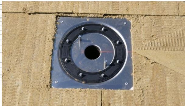
L3 ábra Csomóponti részletek kialakítása vegyes hőszigetelésű tetőnél: felülvilágító beépítése és környezete
