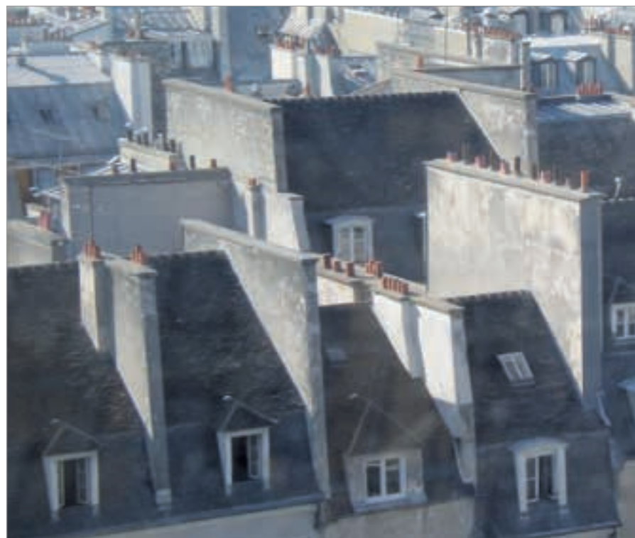
Figura 1.2 - Parigi, vista di insieme delle coperture a falda multipla (fonte: Tiziana Poli)
