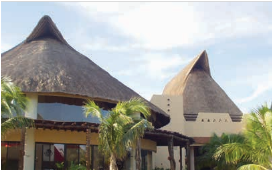
Figura 1.3 - Tetto in paglia, impermeabile e traspirante; tipico delle zone tropicali come lo Yucatan, la sua particolare configurazione permette l'areazione degli ambienti sottostanti (fonte: Sergio Croce)
