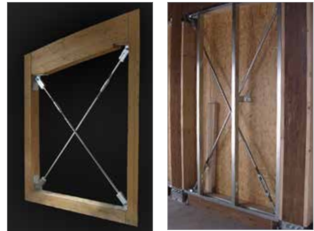
Figura 3.66 - Controventi di parete con elementi metallici a) a vista b) all'interno del pannello
