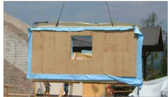
Figura 3.22 - Pannello realizzato parzialmente in officina.
