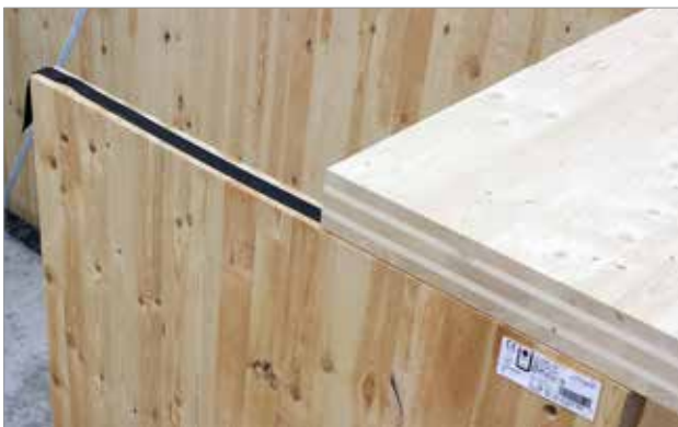
Figura 2.19 - Interposizione di elementi per il taglio acustico fra pannelli XLam.
