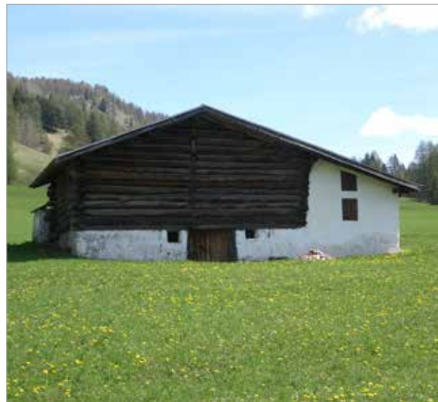
Figura 1.14 - Edificio in legno e muratura in Val di Fiemme (Trentino)..
