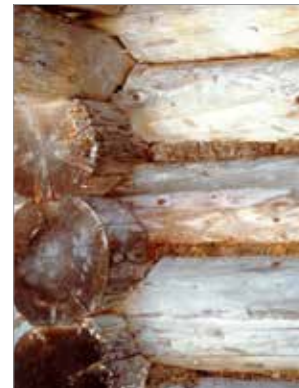
Figura 3.32 - Sistemi di sigillatura con materiali naturali.
