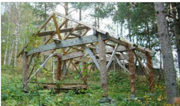
Fig.1.9 - Sistema costruttivo grind (Norvegia).
