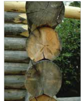
Figura 3.33 - Realizzazione del giunto continuo tra due tronchi.
