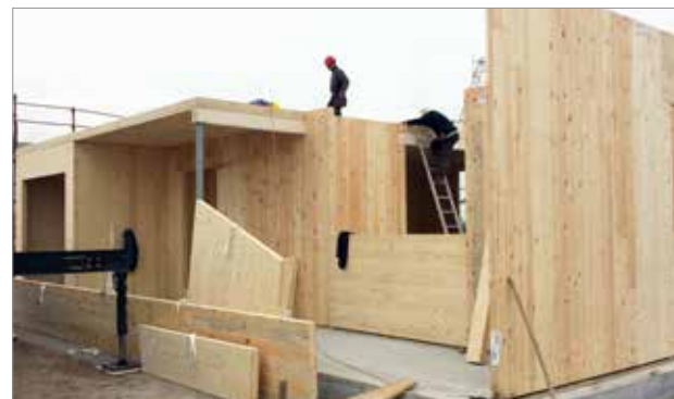
Figura 1.19 - Montaggio di pannelli XLam (Italia).
