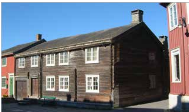
Figura 3.47 - Evidenza della presenza delle pareti interne in un edificio storico (Røros - Norvegia).
