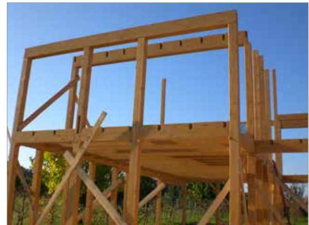
Figura 3.62 - Orditura di travi e pilastri.
