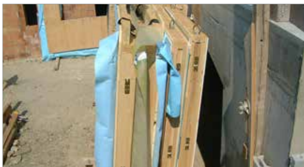
Figura 3.24 - Pannelli prefabbricati equipaggiati con ganci a scomparsa.
