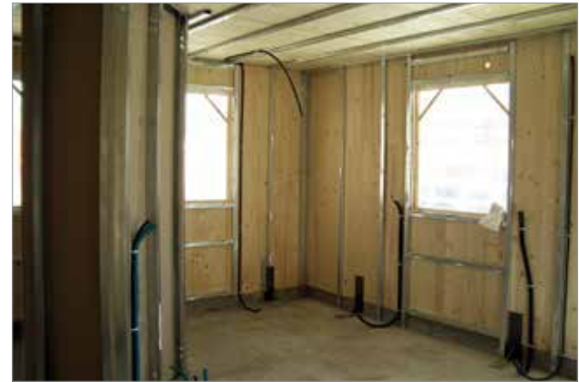
Figura 3.14 - Finitura interna in cartongesso.
