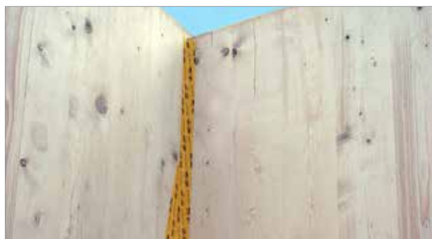
Figura 3.13 - Nastratura per la tenuta all'aria.
