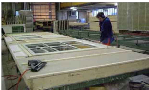
Figura 1.17 - Prefabbricazione di un pannello intelaiato (Norvegia).
