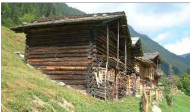
Figura 1.7 - Il sistema costruttivo blockbau (Trentino).
