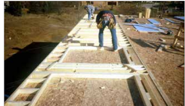
Figura 3.21 - Telai assemblati in opera.
