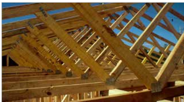
Figura 3.26 - Incavallature leggere in tavole e piastre chiodate.
