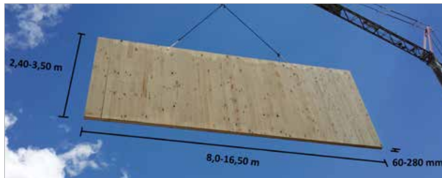
Figura 3.8 - Le dimensioni ricorrenti di un pannello di produzione standard.
