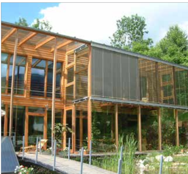
Figura 1.4 - Abitazione unifamiliare a Valdaora (Alto Adige).
