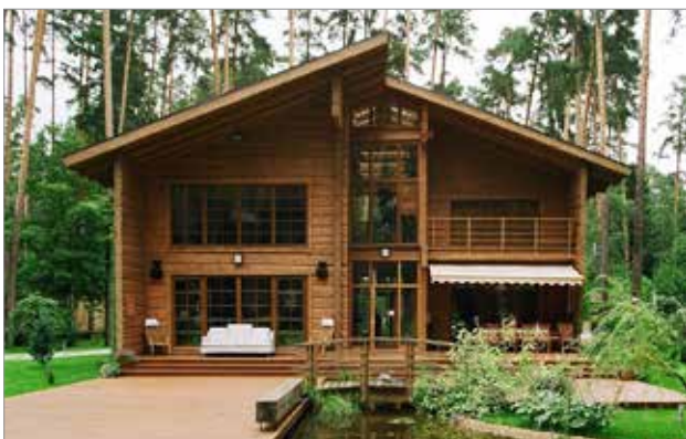
Figura 3.35 - Unità abitativa monofamiliare in Russia.
