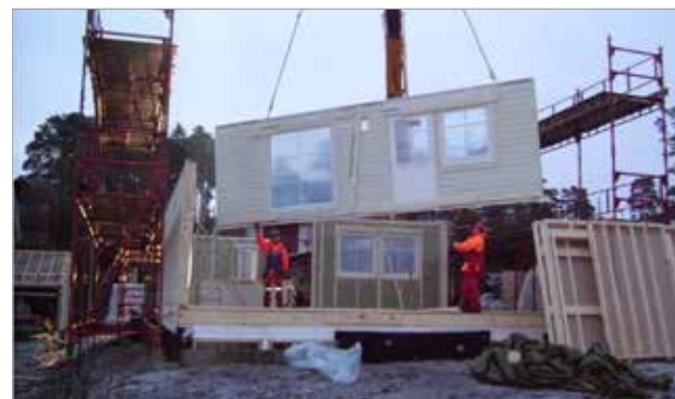
Figura 1.18 - Montaggio pannello intelaiato prefabbricato (Norvegia).
