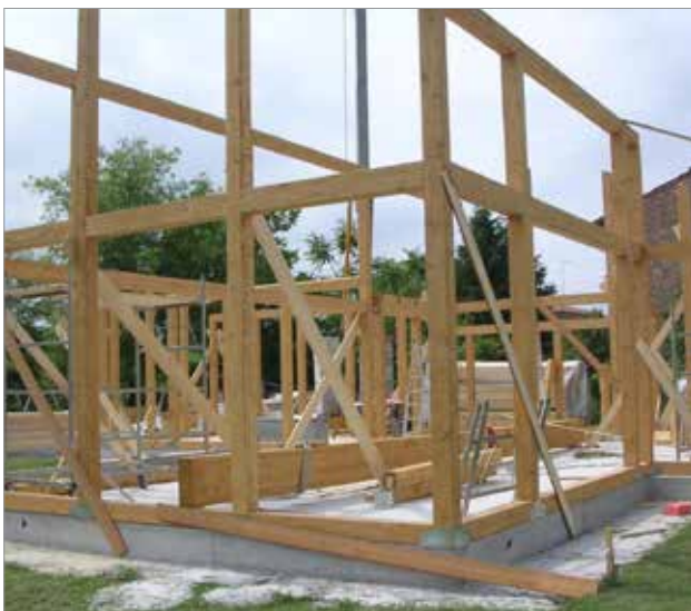
Figura 1.22 - Edificio con sistema costruttivo a travi e pilastri in fase di costruzione.
