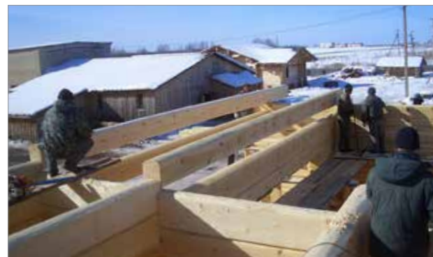
Figura 1.20 - Montaggio di elementi nuovo blockbau (Russia).
