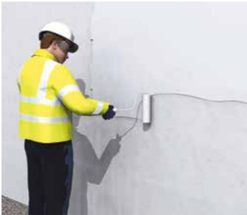
Figura 21 - Applicazione del fissativo (primer) sulla rasatura armata
