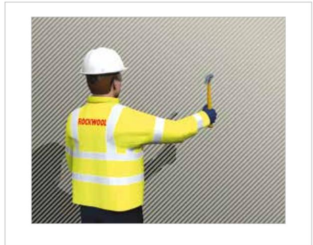
Figura 12 - Verifica della compattezza del supporto mediante piccozzatura
