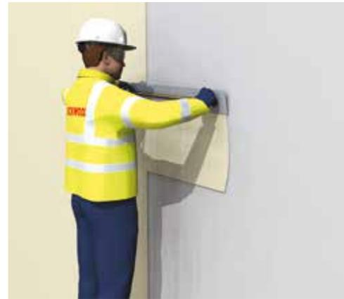
Figura 22 - Applicazione della finitura sulla rasatura armata trattata con fissativo (primer)
