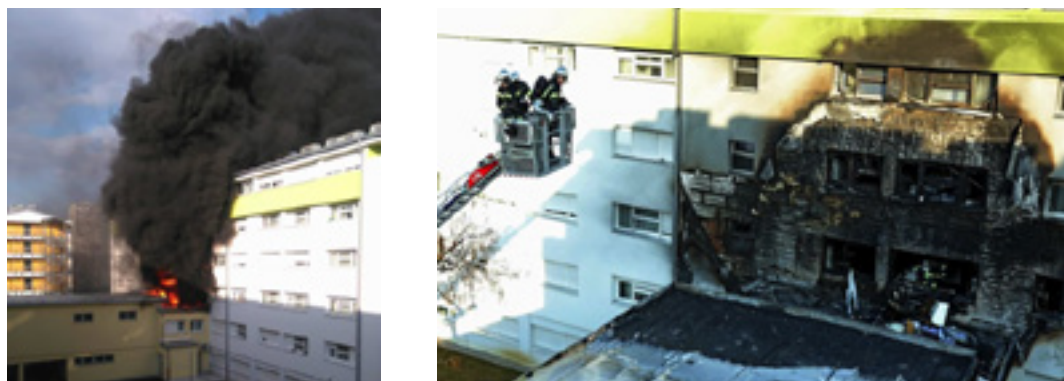
Figura 16. a) Incendio nella Casa dello studente b) aspetto della facciata dopo l'estinzione dell'incendio [11], [25]
