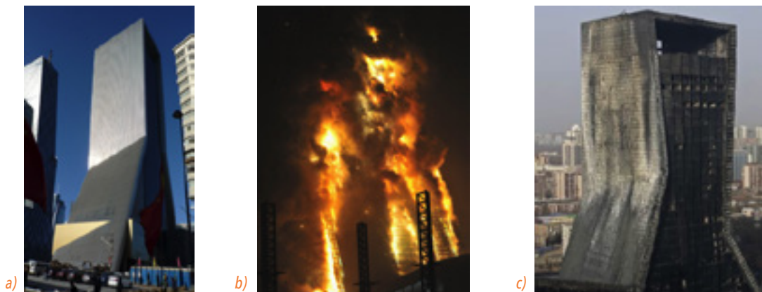
Figura 15. Edificio TVCC a) prima, b) durante e c) dopo l'incendio [22]-[24]
