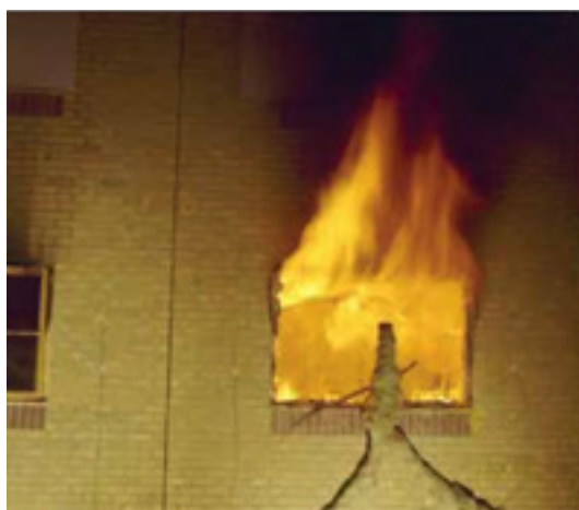
Figura 8. Fuoriuscita delle fiamme dalle aperture di un edificio in muratura, a seguito del flashover [10]
