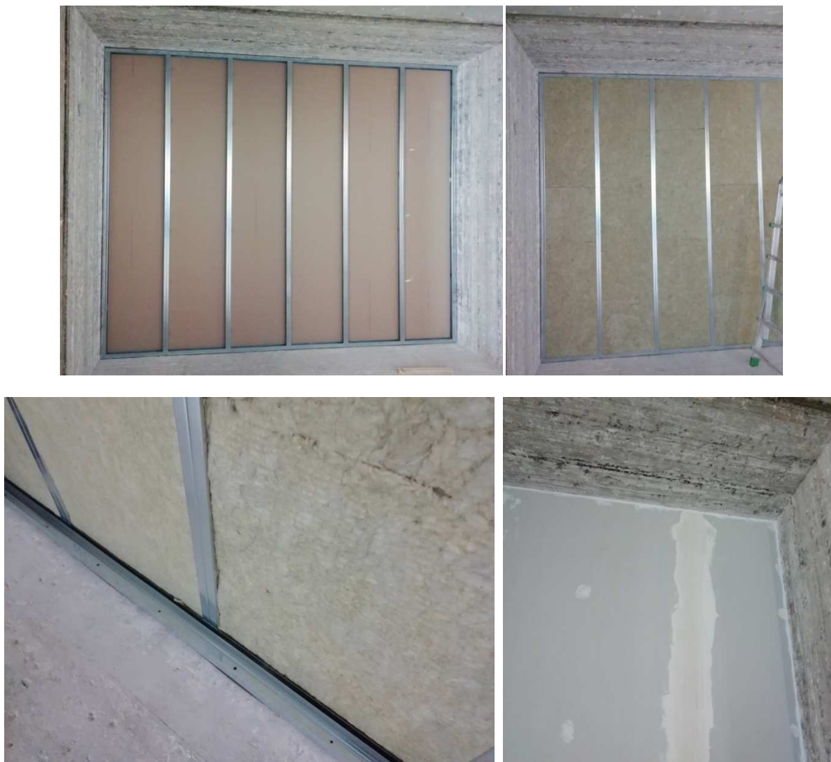
Figura 6_ Fasi della costruzione
