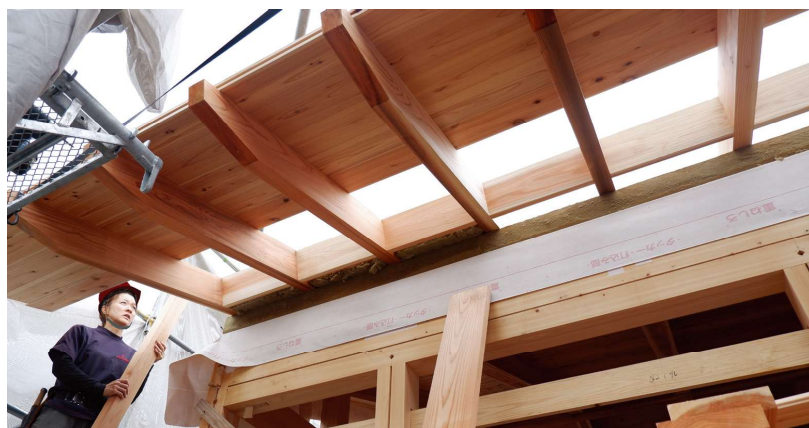
軒部のガイドに沿って通気垂木の設置位置を確認している様子
