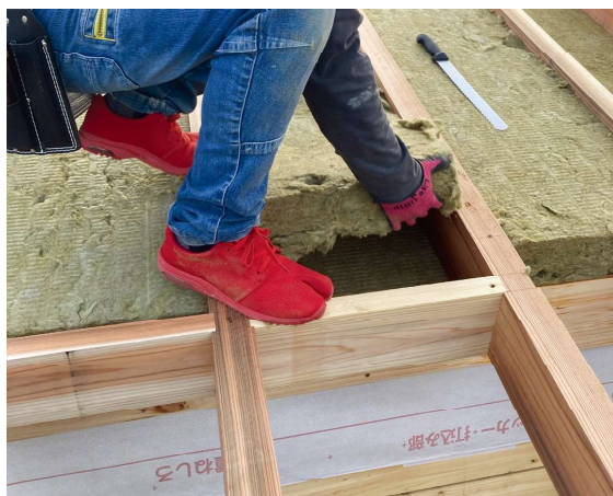
軒部の充填で、通気を確保し設置している様子
