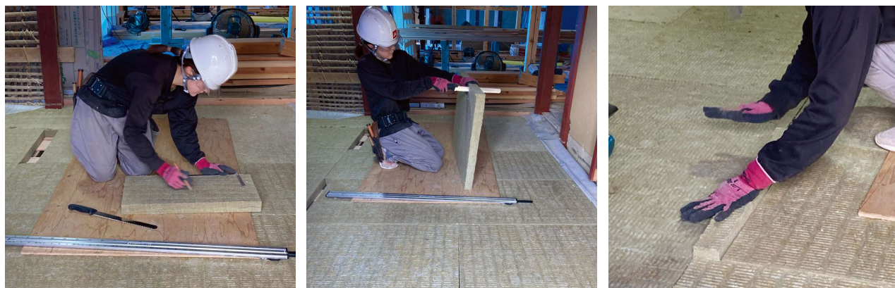
保護材の上での作業の様子。必要寸法を確認し、断熱用ナイフで現場加工をおこなっている様子。
