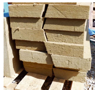
現場加工され、設置前の軒部
