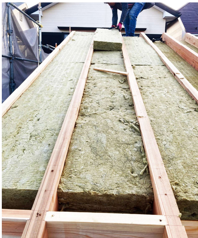
通気垂木間の充填施工の様子
