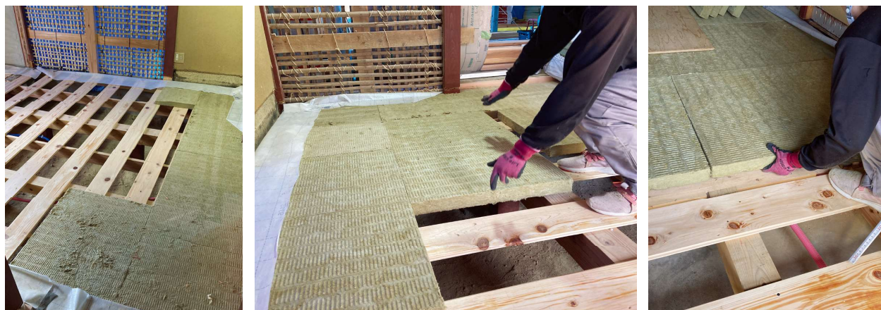
【改修工事での現場写真より】トライロックYuka S150を野地板の上に敷き詰めている様子
