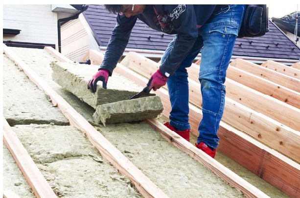
充填用ストーンウールを断熱用ナイフでカットしている様子
