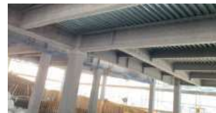
耐風仕様施工例
