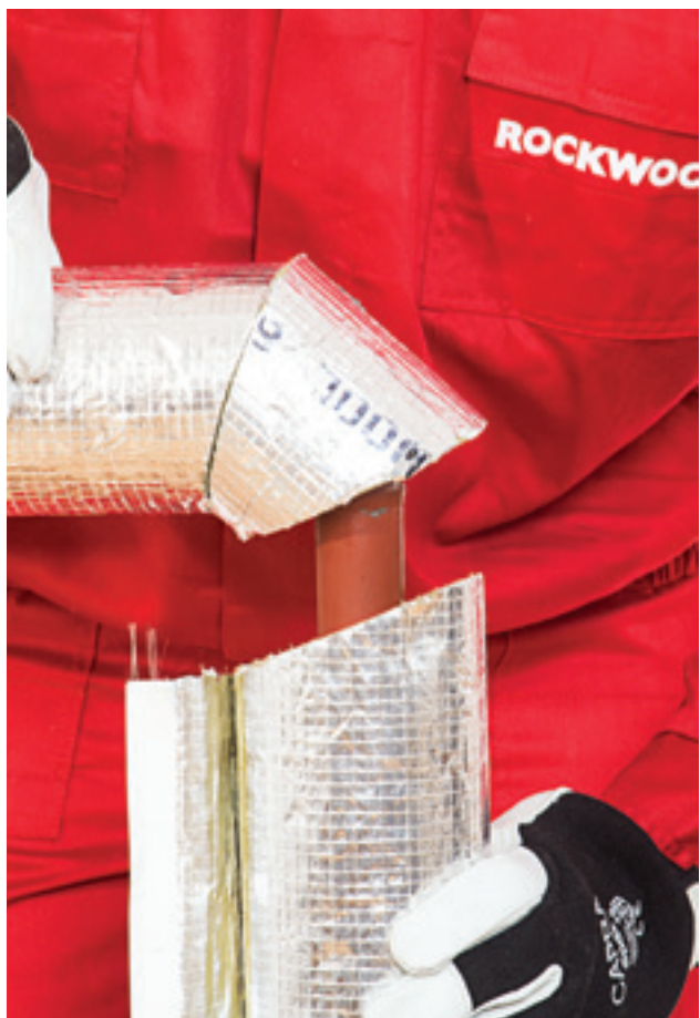
5. Tiesiosios izoliacijos dalies montavimas
