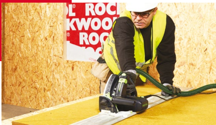
REDAir LINK plokštės pjaustymas su įprastais rankiniais įrankiais
