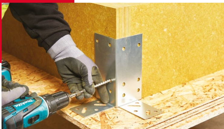
Ilgų varžtų montavimas kampiniame laikiklyje CL / CS
