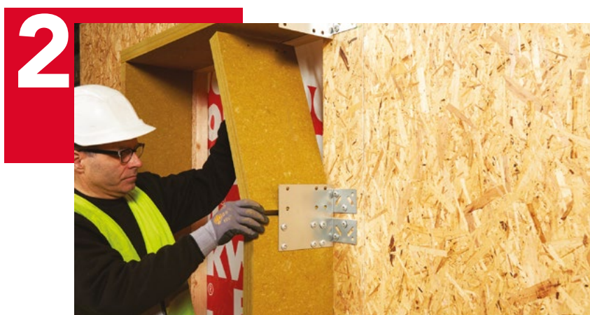
2 REDAir LINK plokštė tvirtinama prie iš anksto sumontuotų laikiklių (EL / ES ir CL / CS)
