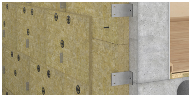
3. Vėjo izoliacinio sluoksnio plokštėmis įrengimas ir tvirtinimas
