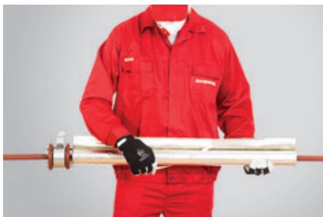
3. Aizsarglentes noņemšana no līpoša pārklājuma
