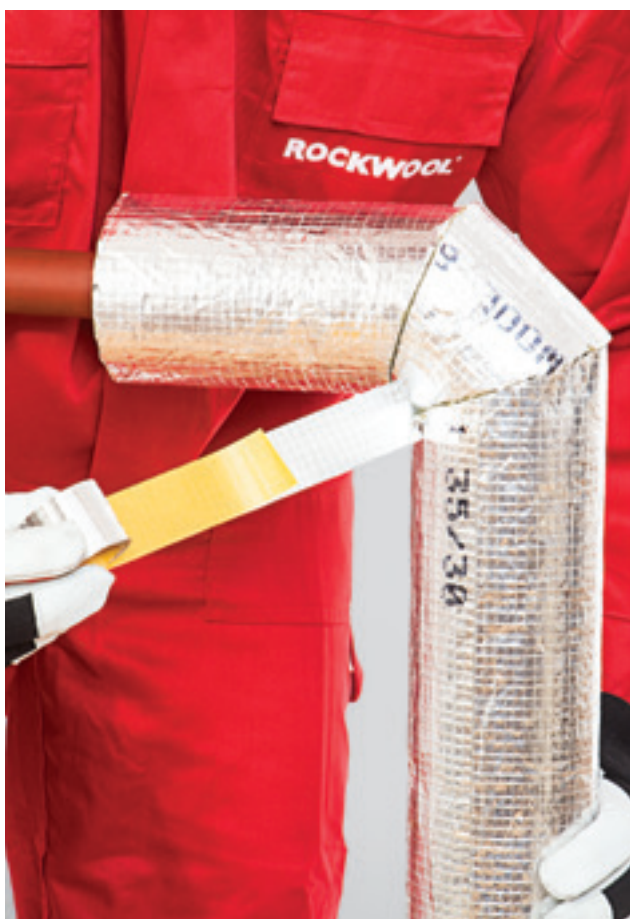
7. Krustojšanās savienojumu aizlīmēšana ar alumīnija līmlentu
