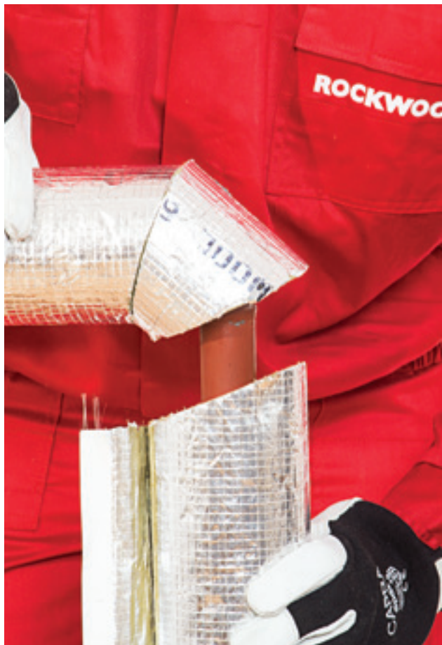
5. Taisnās izolācijas daļas montēšana
