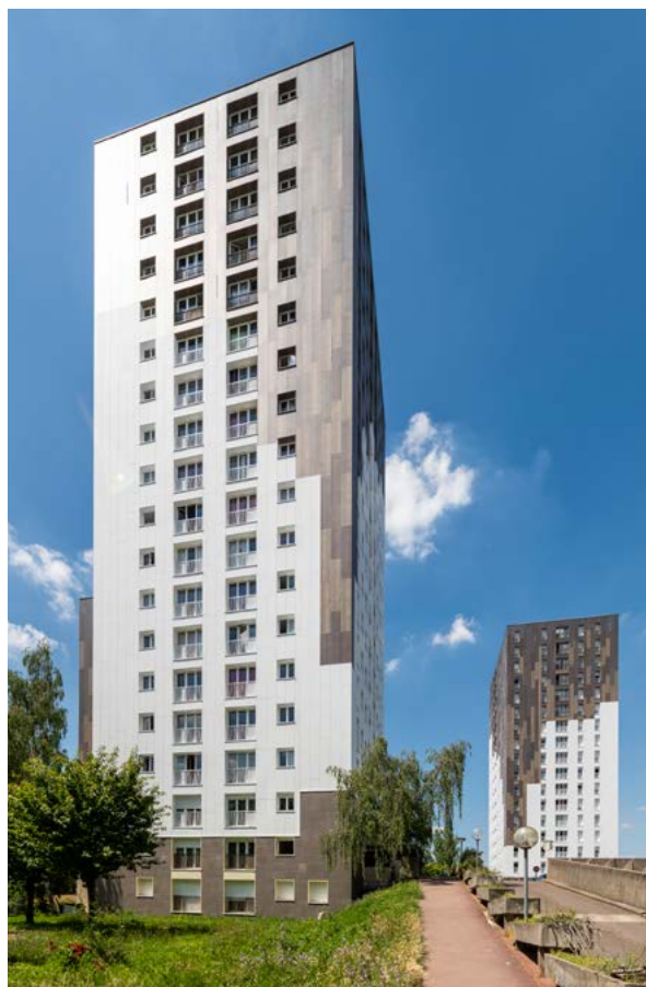
Po lewej: Bievre towers przed termomodernizacją; po prawej: budynki po termomodernizacji z nową okładziną elewacyjną
